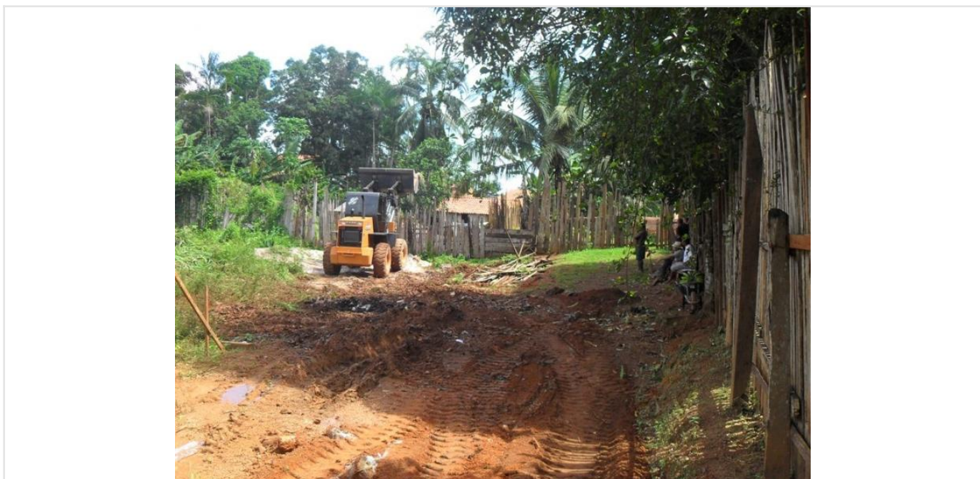
Fotografia antes do início da obra Data da última atualização: 30/05/2013
